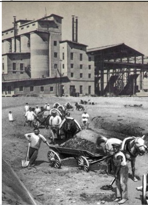
На строительстве Кураховской ТЭС
