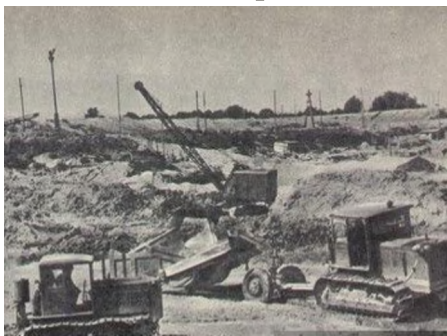
Строительство канала «Северский Донец-Донбасс»
