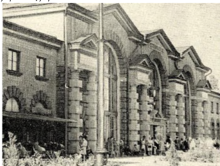
Железнодорожный вокзал в Ясиноватой, построенный в 1952 г.
